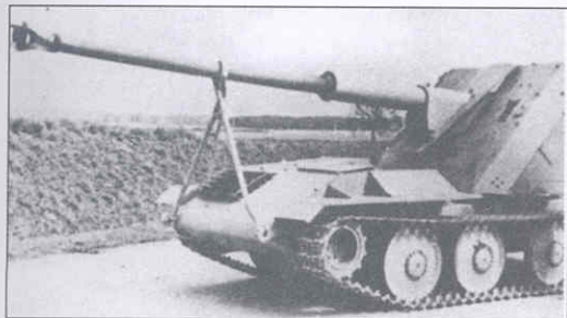
«Транспортеры оружия» (Waffenträger) с 88-мм противотанковыми пушками фирм «Ардельт» и «Крупп». 1945 г.
