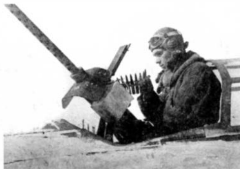
Стоявший в верхней огневой точке пулемет «Кольт-Браунинг» питался лентой из небольших съемных коробов-магазинов
