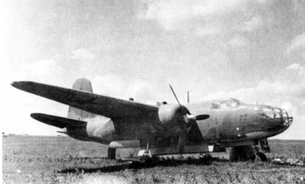
Б-3, ожидающий ремонта, 1942 г. Колеса основных стоек шасси сняты. В это время ощущалась резкая нехватка запчастей к тормозам колес
