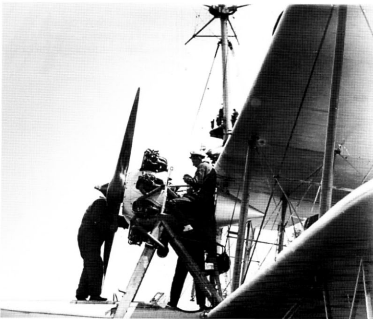
Техническое обслуживание двигателя на самолете КР-1 перед стартом. Хорошо видны структура склейки деревянного винта «Шварц» и детали конструкции двигателя «Сименс» Sh20
