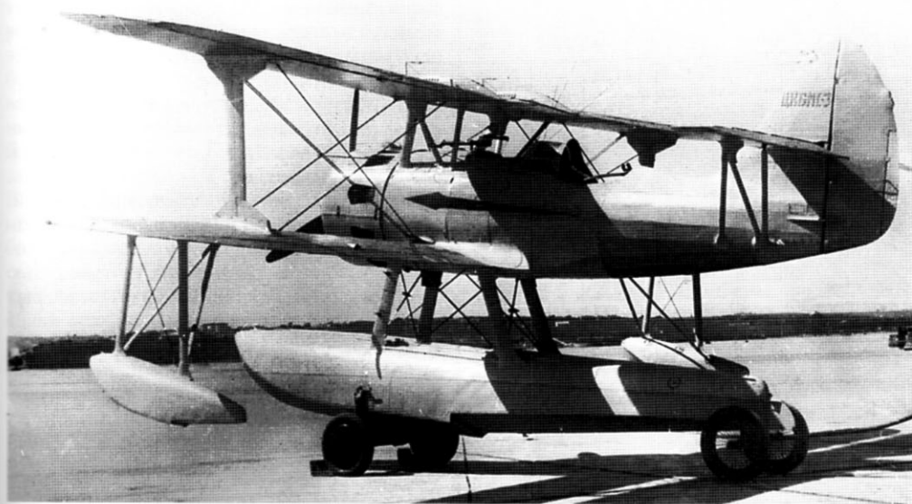
Первый опытный КОР-1 после проведения доводок в процессе испытаний в Севастополе установлен на специальное (выкатное) шасси для передвижения по земле перед спуском на воду. На фюзеляже нарисована стилизованная «стрела», на вертикальном оперении нанесено обозначение опытного экземпляра — ЦКБМС-3
