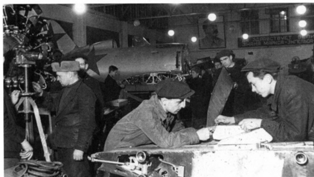
Ремонт поврежденных самолетов на авиазаводе №51 в Москве зимой 1941—42 гг. Указанный завод являлся опытной базой КБ Поликарпова. После возвращения из эвакуации здесь доводились И-185, ИБ и ТИС
