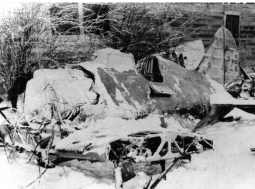
Фюзеляж И-16 тип 5 с хвостовым номером «228» подобрали на месте вынужденной посадки 28 декабря 1939 г. Очевидно, он явился одним из первых поврежденных самолетов, предполагаемых к последующему восстановлению
