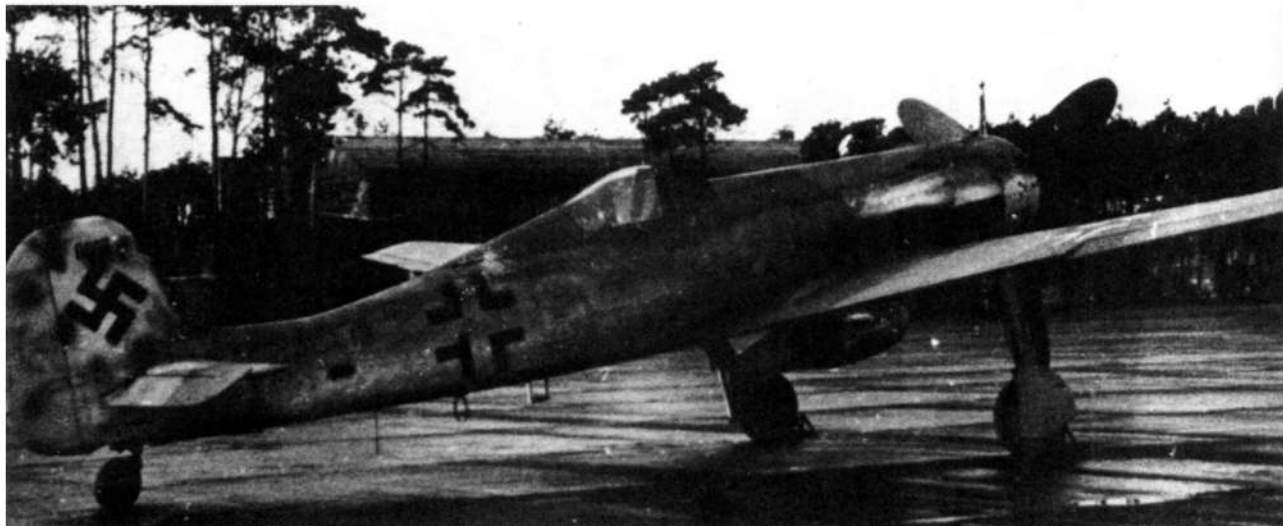
Высотный истребитель Ta 152H-1 с двигателем Jumo 213E-1 отличался очень большим удлинением крыла
