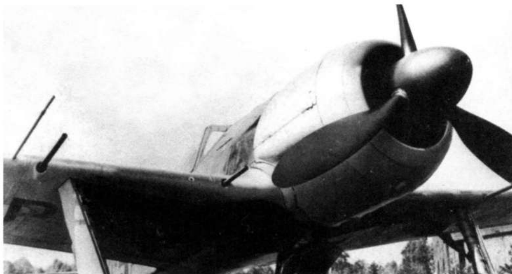
Во внешней части переконструированного крыла FW 190А-6 нашлось место для пушек MG 151, смонтированных взамен менее эффективных MG/FF
