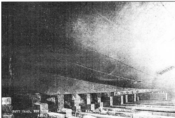
Кормовая оконечность линкора «Ostfriesland». Хорошо видны скуловые кили, скулы корпуса и нижняя кромка броневых поясов. (Фотография сделана 30.12.1920 г. на верфи ВМС в Нью-Йорке)
