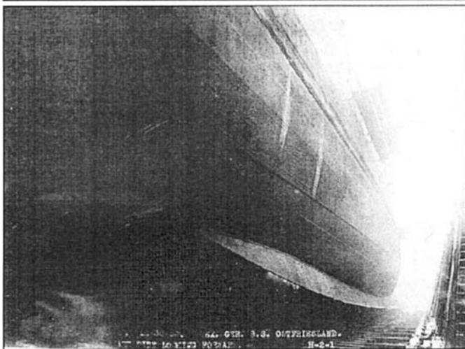
Кормовая оконечность линкора «Ostfriesland». Хорошо видны скуловые кили, скулы корпуса и нижняя кромка броневых поясов. (Фотография сделана 30.12.1920 г. на верфи ВМС в Нью-Йорке)
