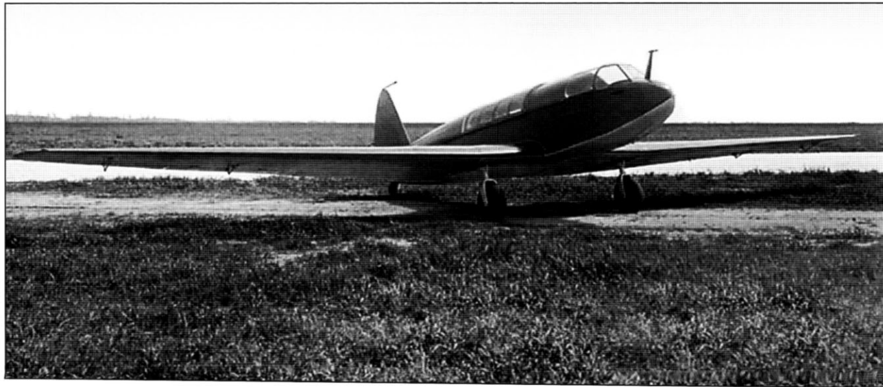
Пятиместный десантный планер КАИ «Сокол» конструкции Г.Н. Воробьева. Обратите внимание на изящные формы планера и на крыло большего удлинения. В правом нижнем углу затерта надпись. По-видимому, номер фотографии, «Сов. секретно», и дата: 29 (или 24) 8 (или 6) 41. Фото сделано в ЦАГИ. Сейчас принадлежит Росархиву
