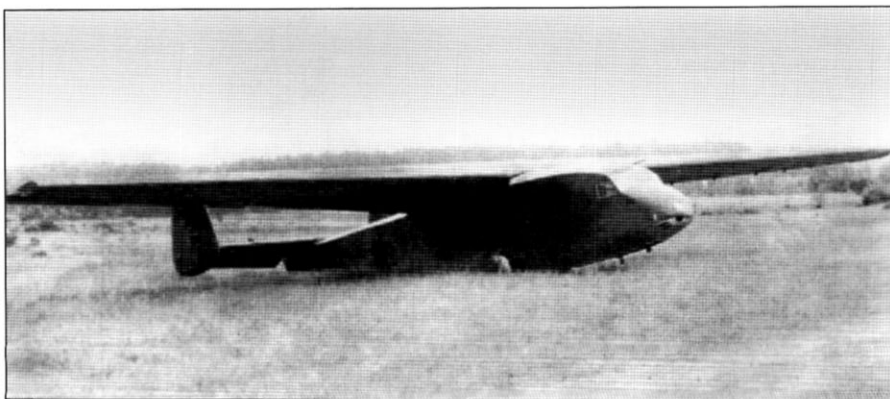
Серийный десантный планер КЦ-20. У планера отсутствует законцовка правого крыла
