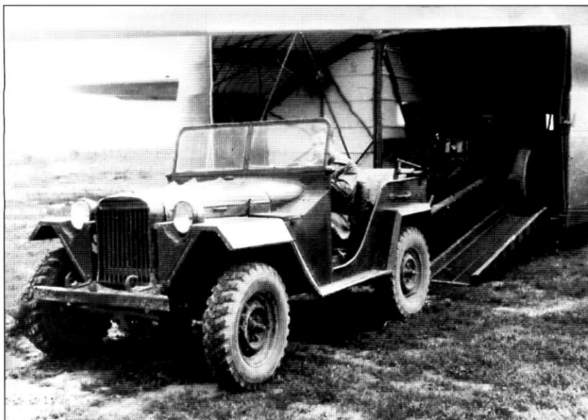
Тягач ГАЗ-67Б выгружает 57-мм пушку из Як-14. На подволок носового обтекателя виден шаровой баллон воздушной системы
