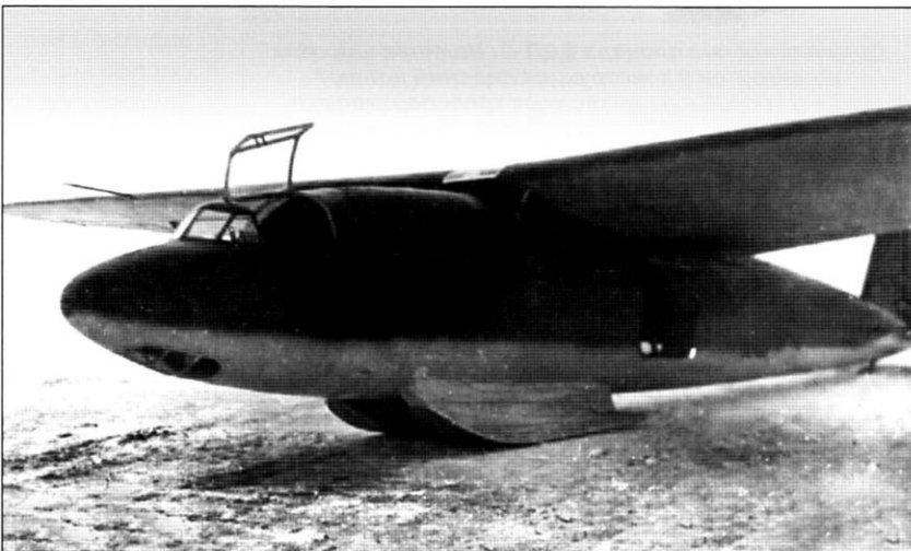
Планер БДП-2, вид спереди. Створка фонаря кабины пилота открыта. В аварийной ситуации ее можно сбросить. В низу носовой части сделан иллюминатор для обзора земли пилотом. Грузовая дверь в левом борту открывалась вверх. Размеры посадочных лыж увеличились. Место их сочленения с фюзеляжем закрыты полотняным обтекателем. На правом крыле видна трубка ПВД
