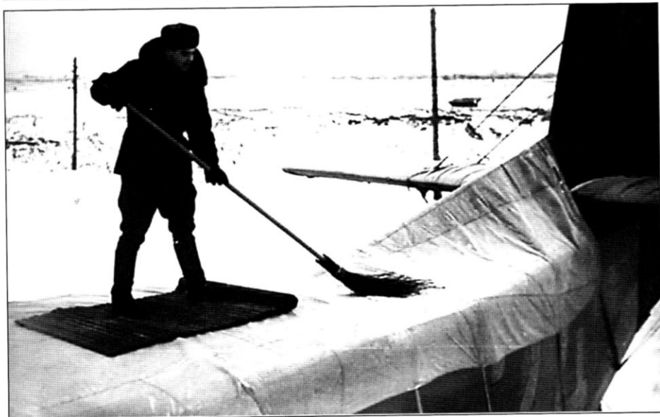
Уборка снега с планера. Чтобы не продавить полотняную обшивку, подстилали специальные маты. Этот планер имел бортовой номер 24
