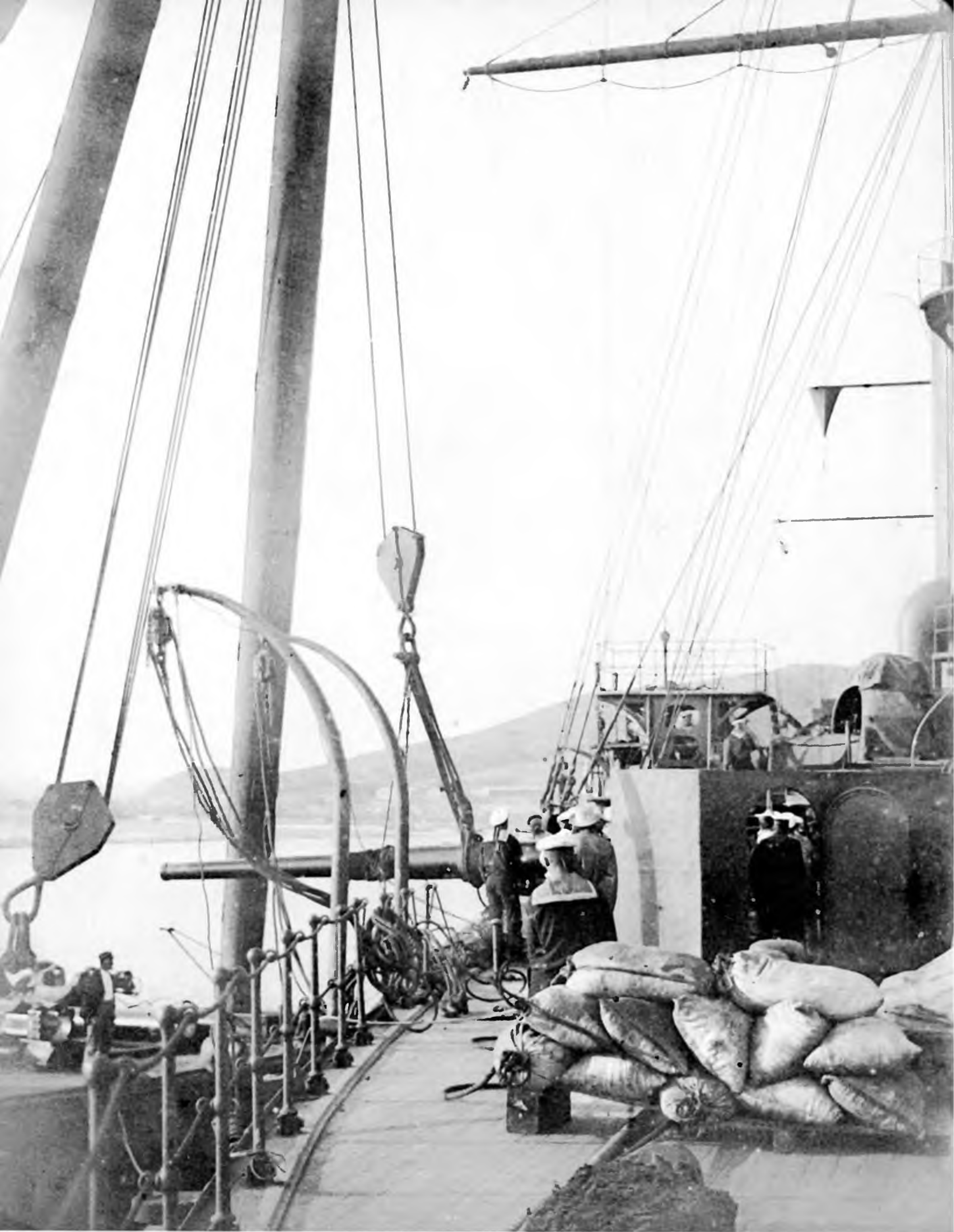
Крейсер «Паллада» в Порт-Артуре. Демонтаж 152-мм орудия с помощью плавучего крана, 1904 г.
