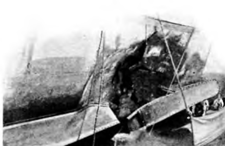
Крейсер «Паллада» в доке: пробоина от японской торпеды, поразившей корабль в ночь на 27 января 1904 г.
