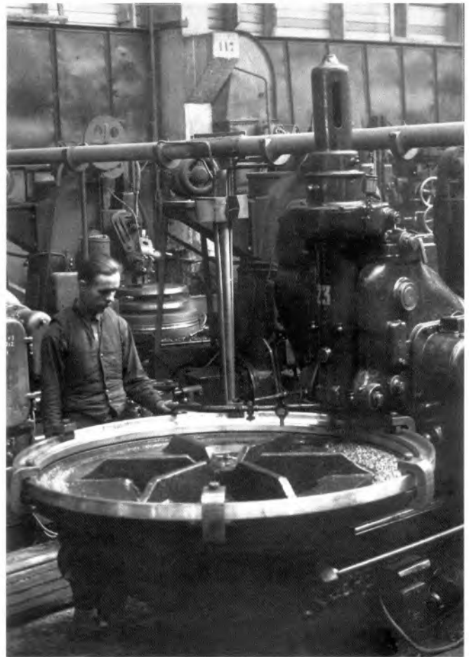
Нарезка зубьев погона башни на заводе №183. 1942 г.
