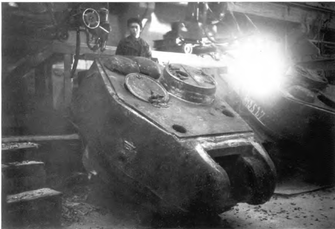
Автоматическая сварочная установка для приварки крыши к корпусу башни. 1944-1945 гг.
