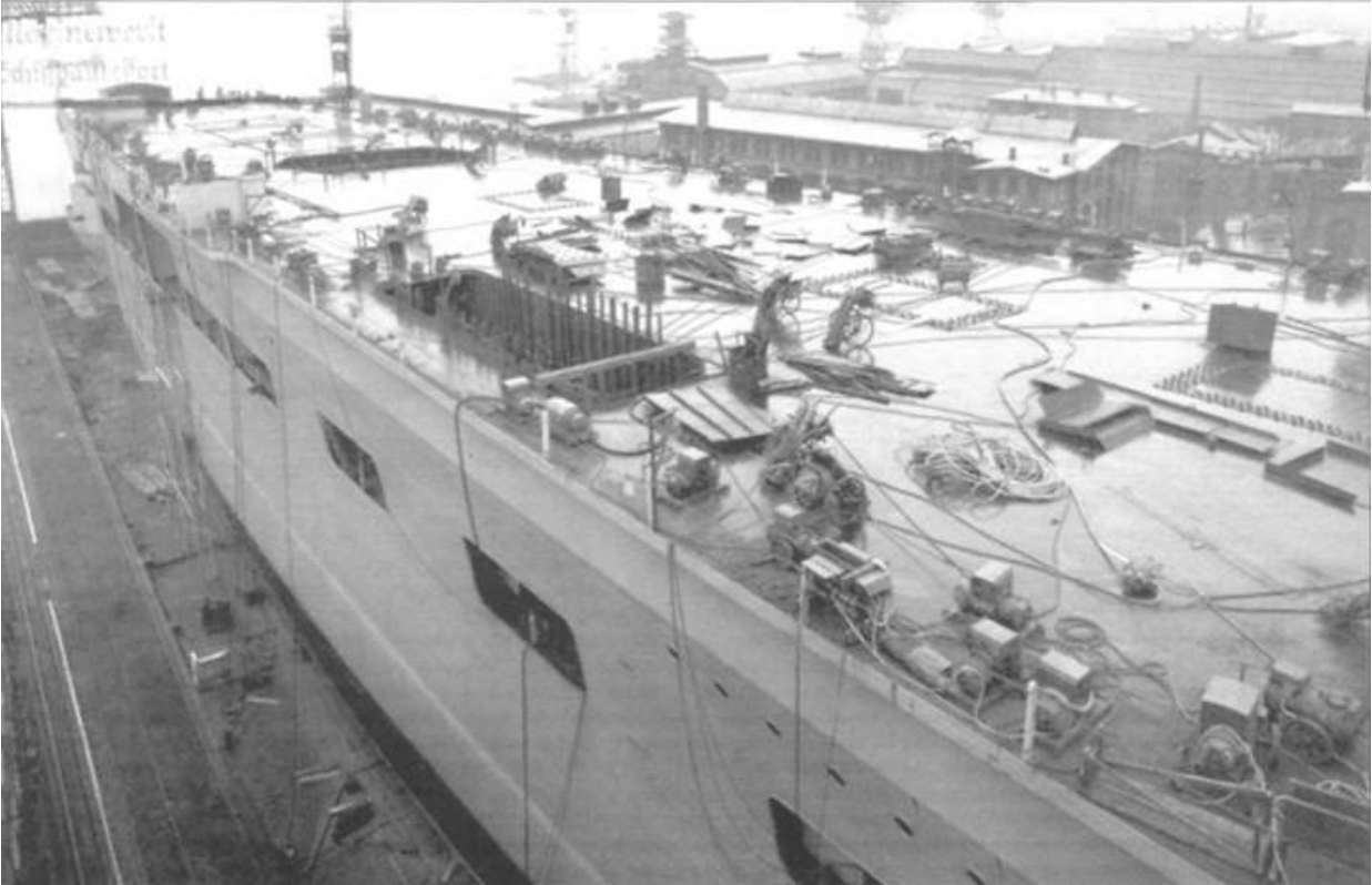
Монтаж оборудования на полетной палубе корабля
