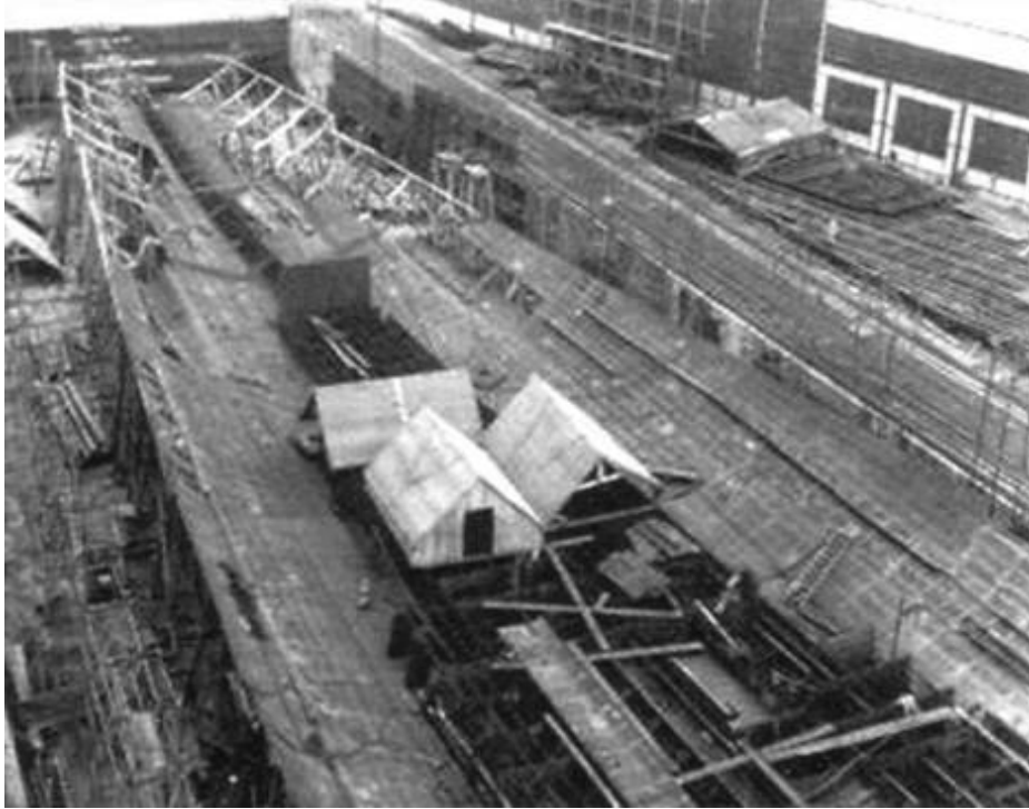
Первый этап строительства корпуса авианосца Graf Zeppelin
