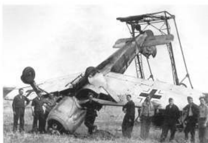
С помощью специального крана немецкие механики поднимают Fw.190A из JG51, который скапотировал при посадке
