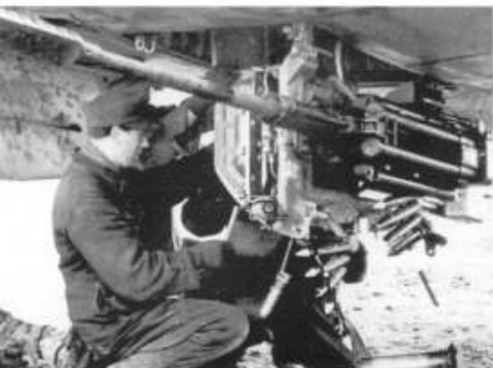
Механик снаряжает пушку Mk 103. Такое оружие немцы с успехом применяли против танков благодаря использованию подкалиберных снарядов
