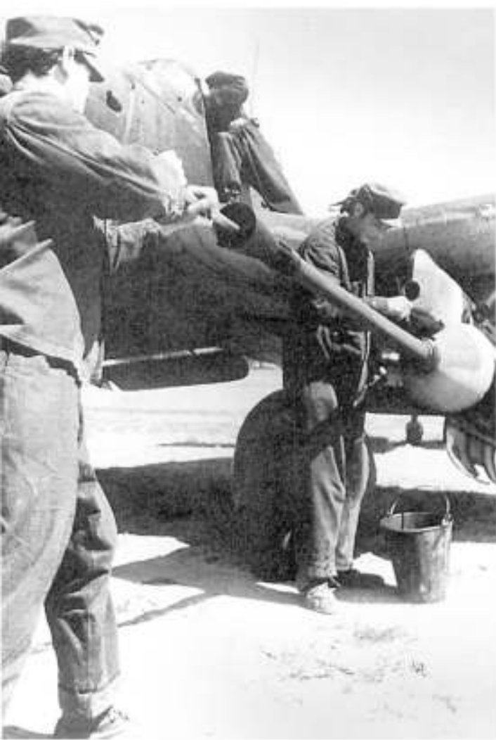
Немецкие механики устраняют нагар в стволе 37-мм пушки, не снимая ее с самолета Ju.87G
