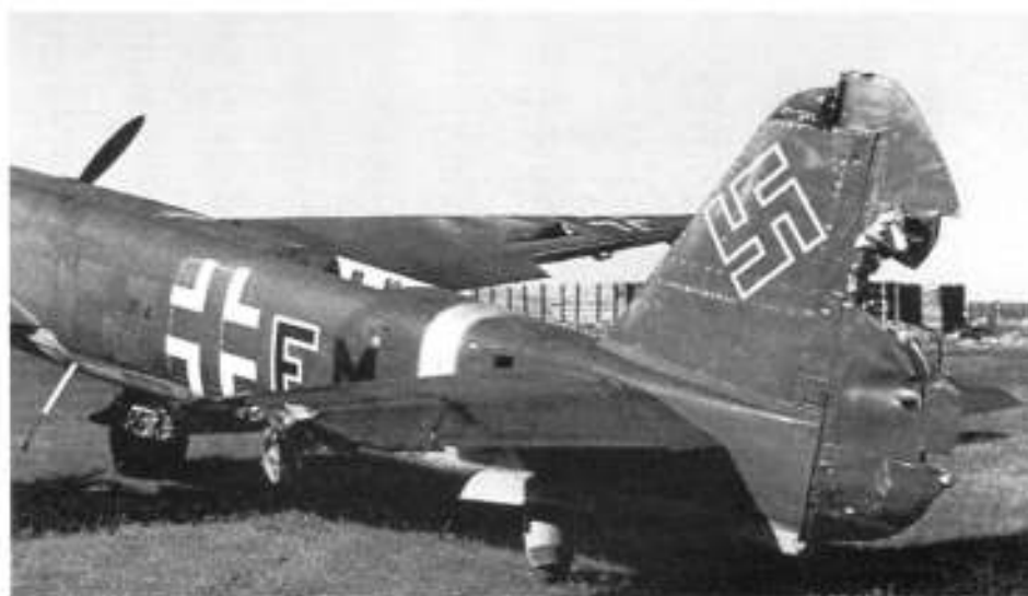
Разведчик Ju.88D из отряда 4 (F)/121 вернулся на аэродром Сечинская с повреждениями от попадания 85-мм зенитного снаряда
