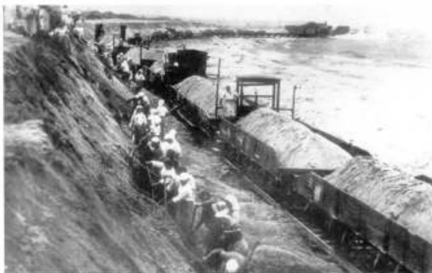
Отгрузка балласта при строительстве насыпи
