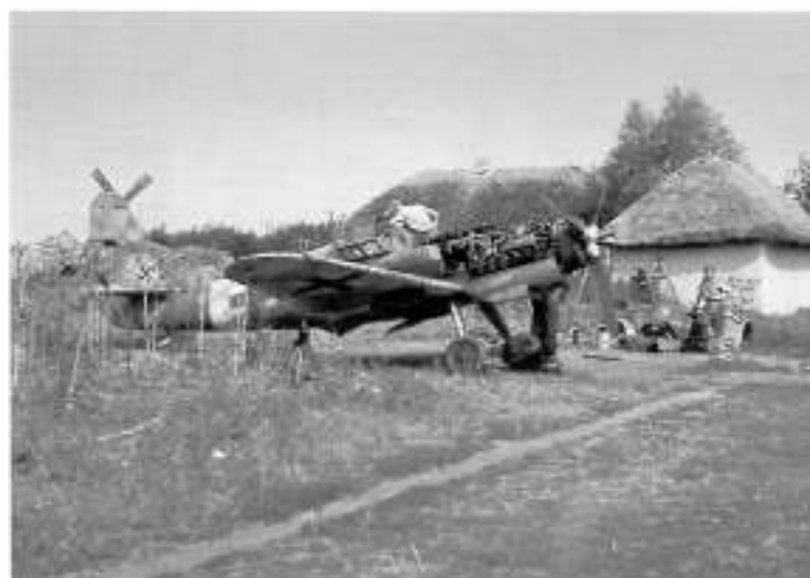
Интенсивное использование материальной части потребовало большого напряжения от немецких механиков. Проверка работы агрегатов мотора DB 605A
