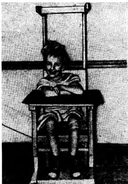
Рис. 36. Сидение на приспособленном стуле с прибитыми ручками, подставкой для ног, с накладным столиком; ноги фиксированы прибитой к доске обувью. К спинке стула приделана «стойка» для крепления петли Глиссона.
