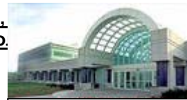
Рис. 1.11. Новая штаб-квартира ЦРУ, откуда и должны подрывать интеллектуальную безопасность страны до подписания Договора о прекращении холодной войны.
