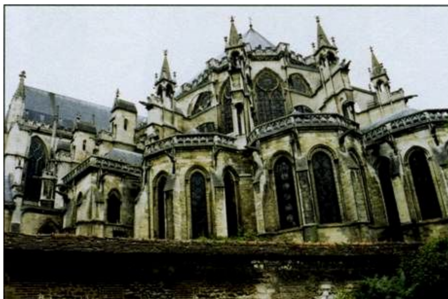
XII. Собор в Труа. Вид с востока.
