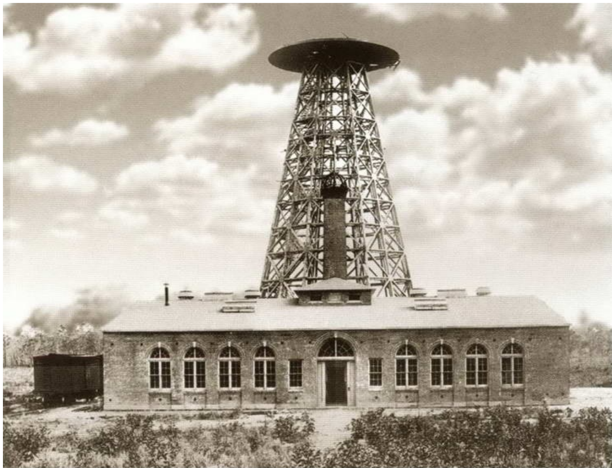
Башня для «Мировой системы» Теслы с излучателем и зданием лаборатории на Лонг-Айленде. Предназначалась для передачи энергии без проводов
