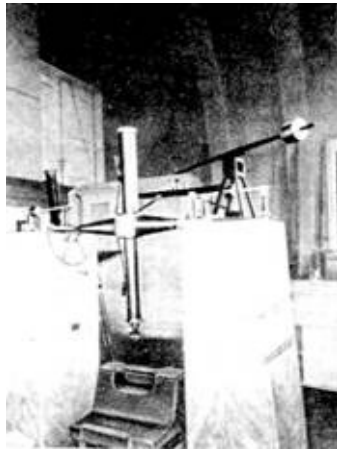
Пассажный инструмент Доллонда.
