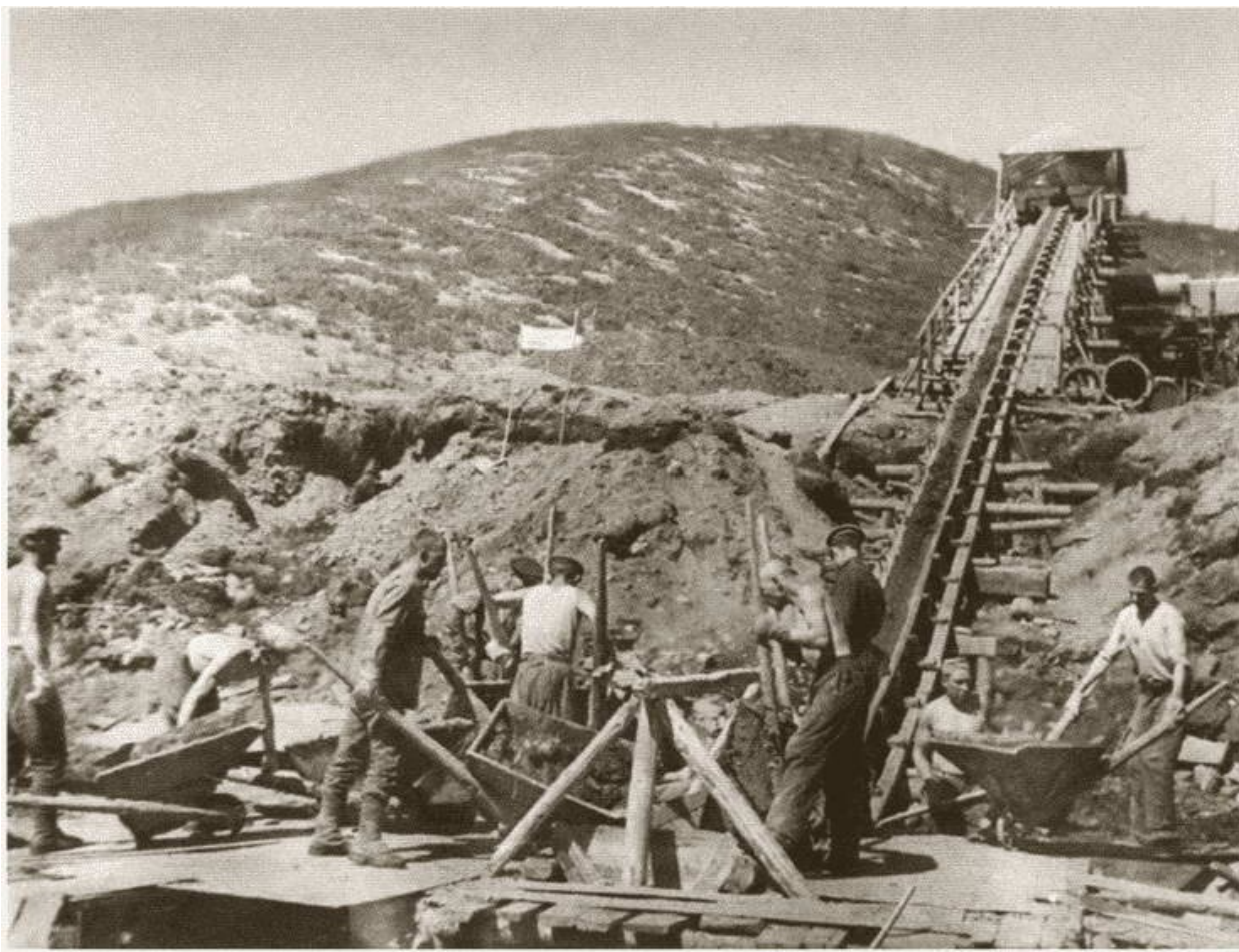
Прииск. Мускульная подача песка на промприбор
