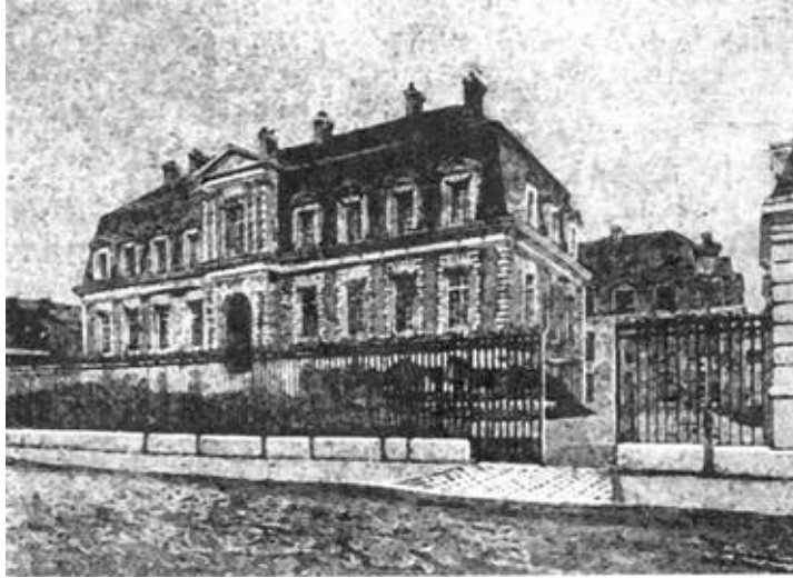
Здание Пастеровского института в Париже.
