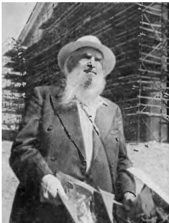
На строительстве Петрозаводского театра.
