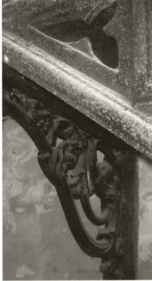
Кронштейн лестницы в усыпальнице Демидовых
