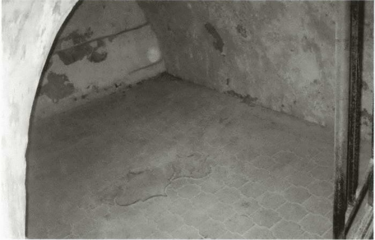
Склеп Демидовых в церкви Николая Зарецкого (современное состояние)
