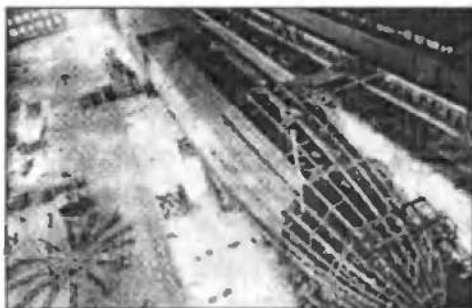
Рис. 287. Сборка дирижабля ZS-1 Shenandoah (1924 г.)
