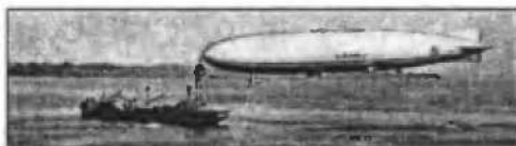
Рис. 203. Дирижабль «Шенандоа» на причальной мачте судна «Патока»
