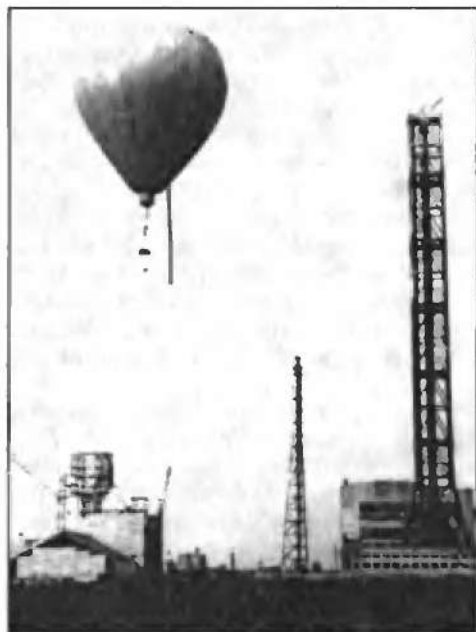
Рис. 92. Аэростат-кран ЭПАК-1
