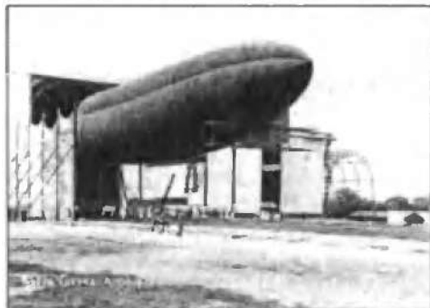
Рис. 234. Мягкий дирижабль «Астра» вводится в элинг. Высокая ширма предохраняет дирижабль от порывов ветра
