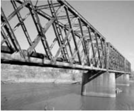
Мост со сквозными фермами
