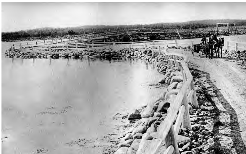
Рис. 9.2. Валунная дамба на остров Муксалма. Построена и сфотографирована в XIX веке
