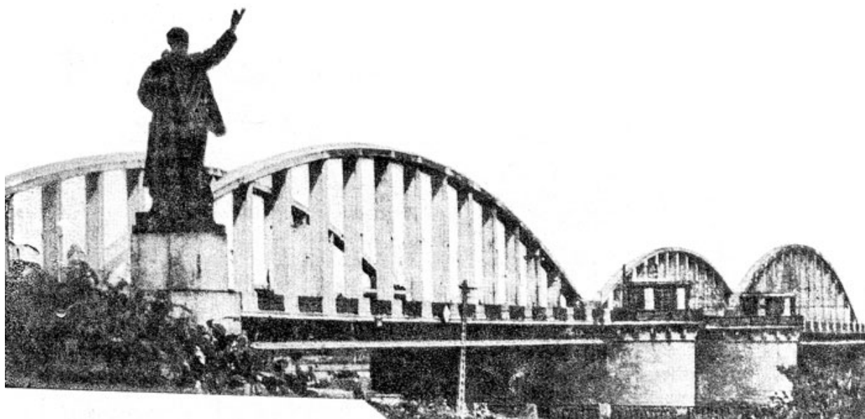
Арочный мост «с ездой понизу» — Володарский мост через Неву в Ленинграде. Инженер Г. П. Передерий. 1932— 1936 годы. Пролёт арки — 100 метров.
