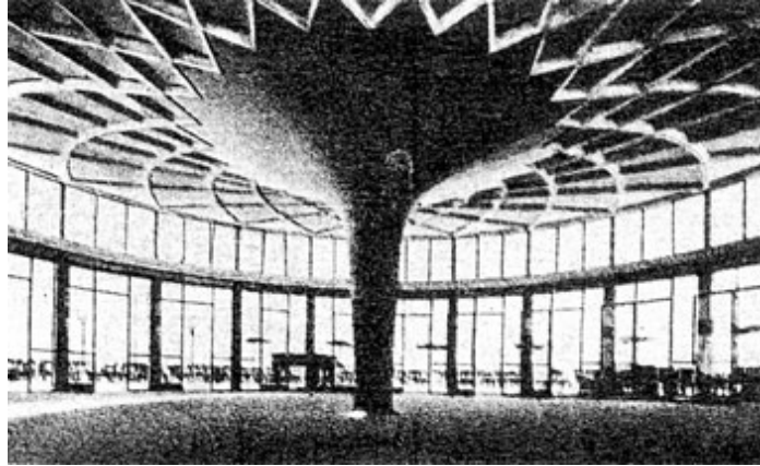
Ресторан в Остии (пригород Рима). Инженер П.-Л. Нерви. 1950 год. Диаметр грибообразного покрытия — около 15 метров.
