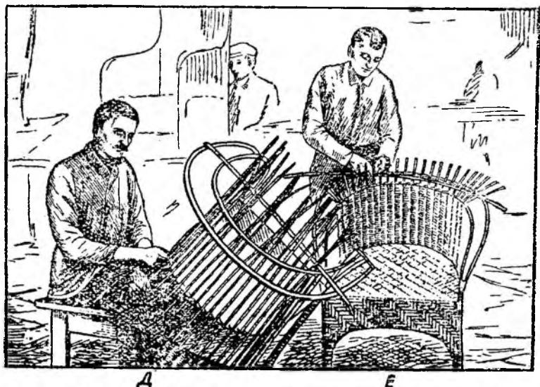
Рис. 91. Плетение спинки и устройство основы на ее кромке
