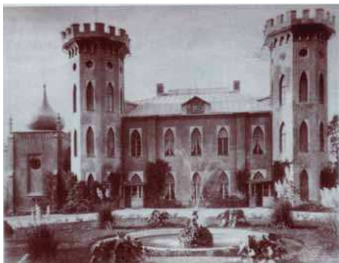
Гаспра. Замок-дворец, северный фасад. Слева – купол домовй церкви, не сохранился. Фото 1860 г. АГДПМЗ
