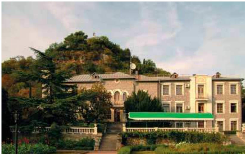
Винный погреб в виде замка. Архитектор Карл Эшлиман, 1830-е годы. Перестроен при Юсуповых. Современное фото
