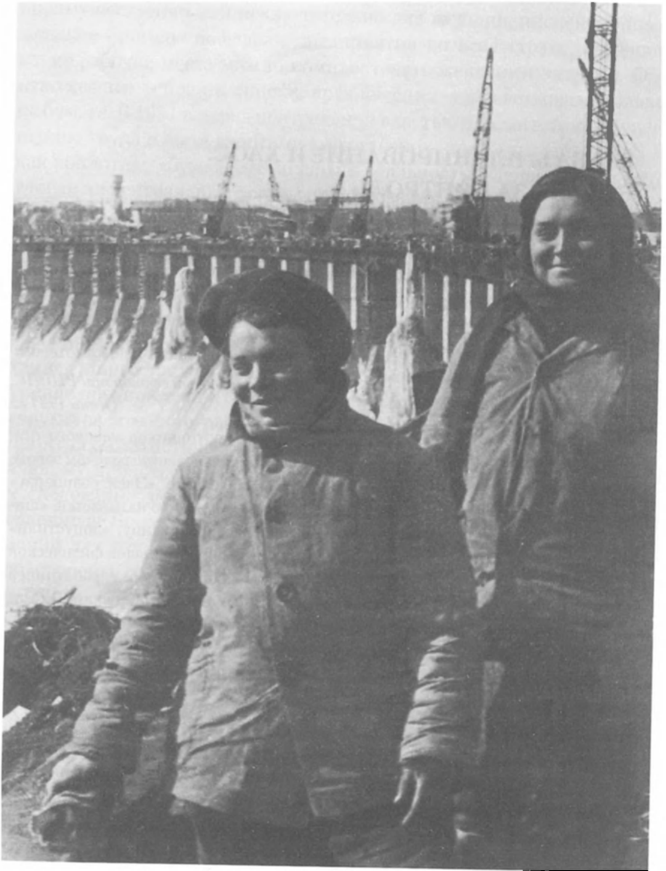
Бетонщицы-ударницы Дасюк и Яновская на строительстве ДнепроГЭС. Украина. 1932 г.
