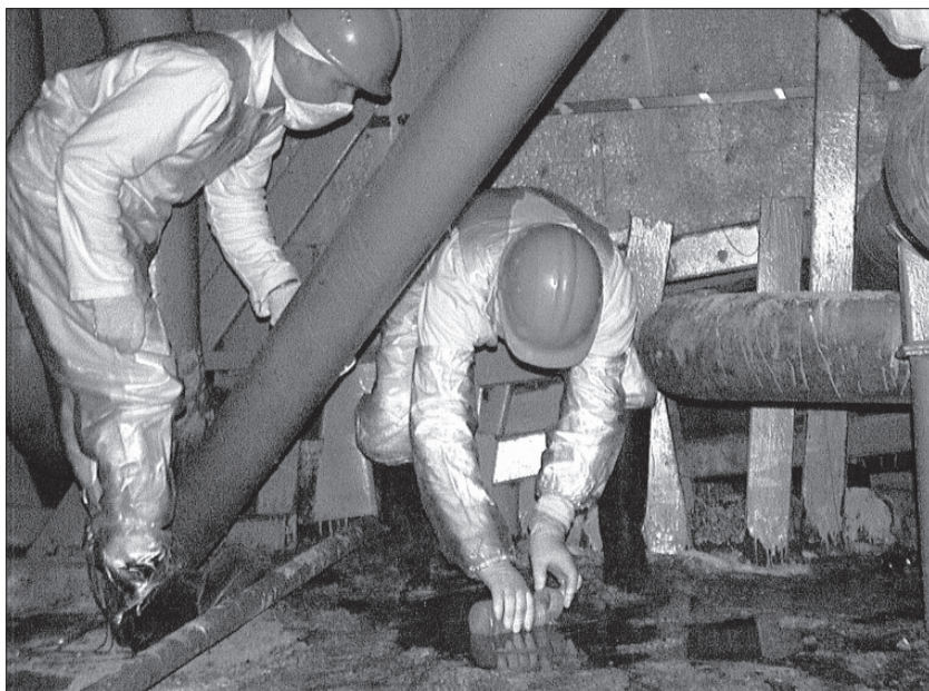
Отбор проб воды в одном из помещений бассейна-барботера
