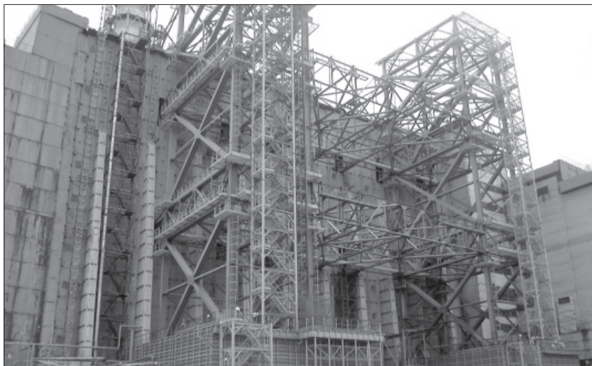
Проведение работ по строительной стабилизации конструкций объекта «Укрытие» (западная стена)
