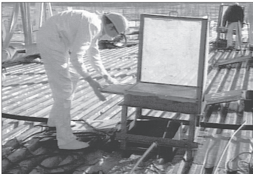
На кровле объекта «Укрытие». Смена рамки на планшете для отбора радиоактивных аэрозолей
