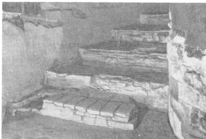
Рис. 4. Дополнительная ступень верхнего марша лестницы, сложенная в XVII—XVIII вв. из кирпича на известково-песчаном растворе.
