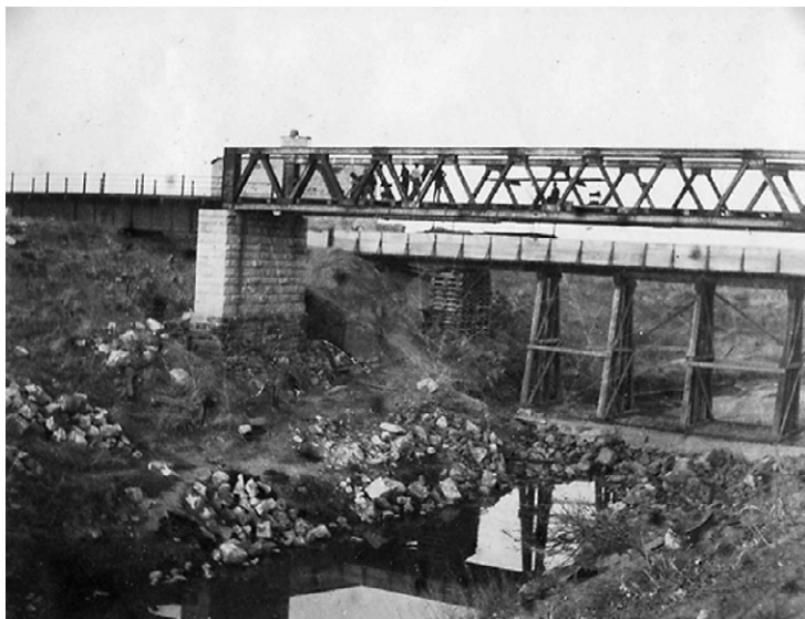
Починка Реностерского моста, взорванного бурами
