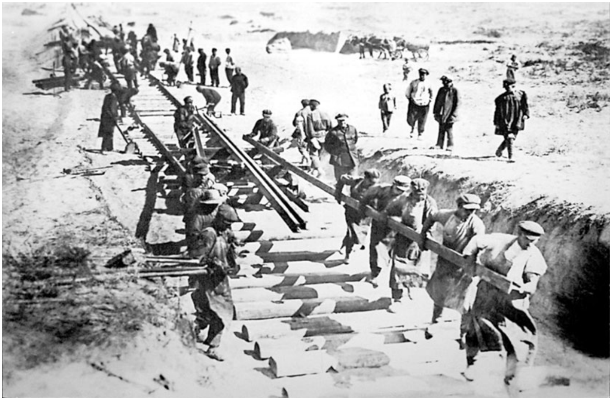
Укладка рельсов на трассе Турксиба. 1929 г.
