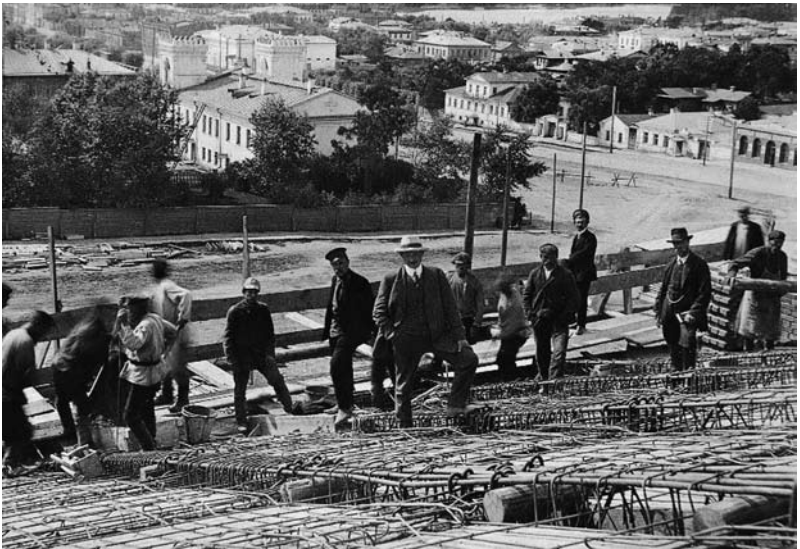
Екатеринбург. Вид с крыши строящегося Оперного театра.
