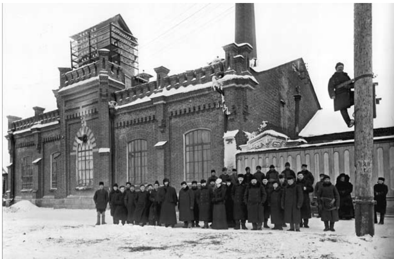
Электростанция в г. Екатеринбурге
