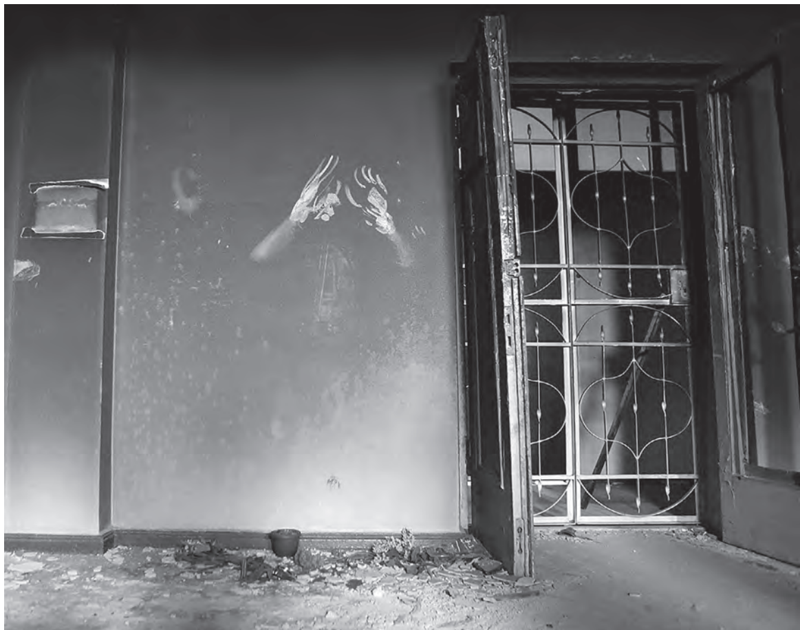
Следы гибели одной из жертв расправы на стене Дома профсоюзов Одессы. 2014
