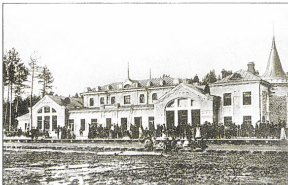
Вид на железнодорожный вокзал. Фото 1910 г.
