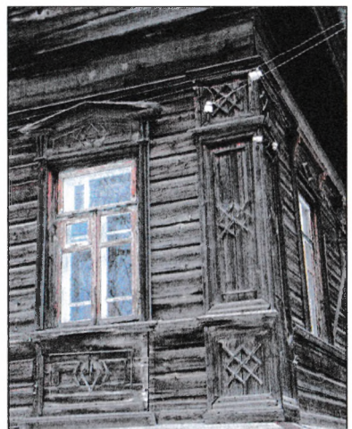
Резная обшивка фасадов
