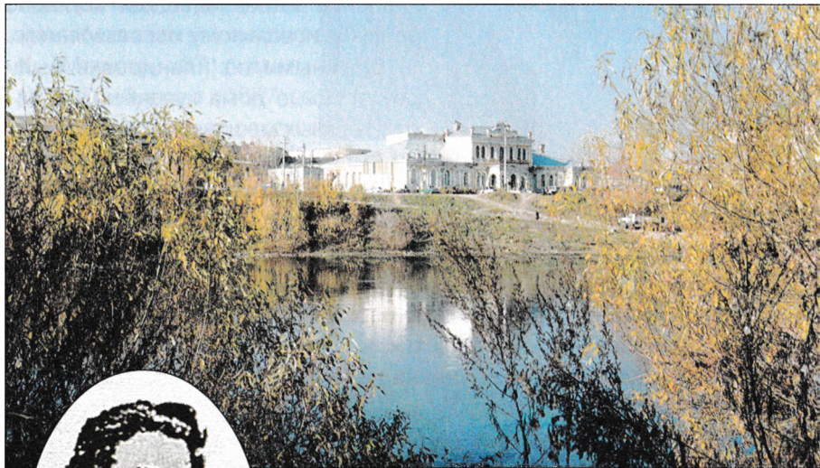
Особняк купца Г.К. Кузнецова. 1870 г. (К. Маркса, 27). Фото 2006 г.
