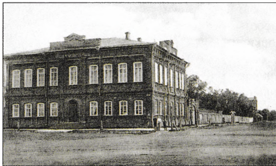
Здание городского четырехклассного училища. Фото 2006 г.
