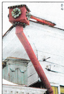
Воронка водосточной трубы
