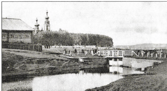
Вид г. Осы. Мост через р. Ершовку. Начало XX в.
