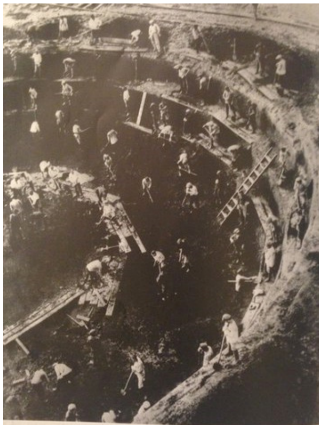
Строители Магнитогорского комбината работают на рытье котлована для доменной печи
