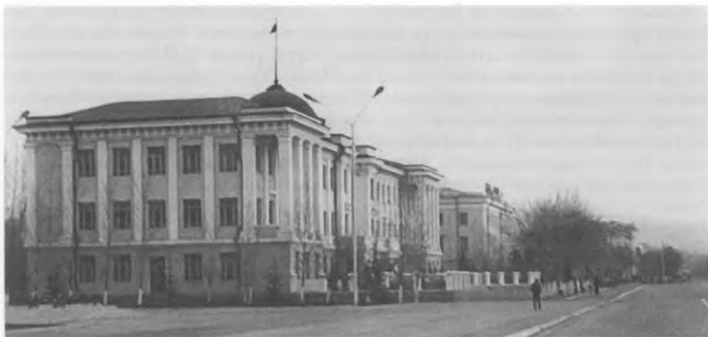
Здания правительства в Кызыле. Фото С.И. Вайнштейна, 1983 г.
