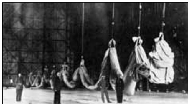
Взвешивание оболочки дирижабля «СССР В-6» в эллинге «Дирижаблестроя»
