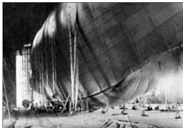
Газонаполнение оболочки дирижабля «СССР В-6»
