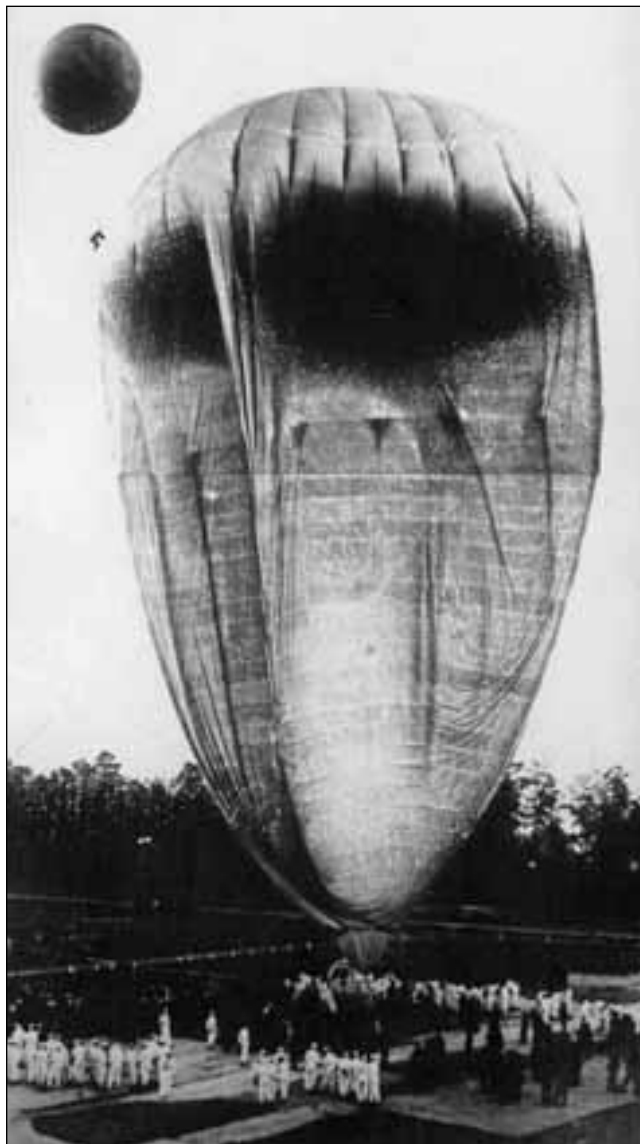
Пилот шара-прыгуна проверяет состояние оболочки «СССР-1 бис»
