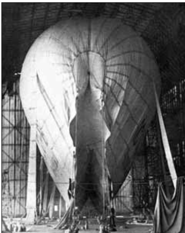
Оболочка дирижабля «СССР В-7 бис» «Челюскинец» в эллинге «Дирижаблестроя». Установка киля
