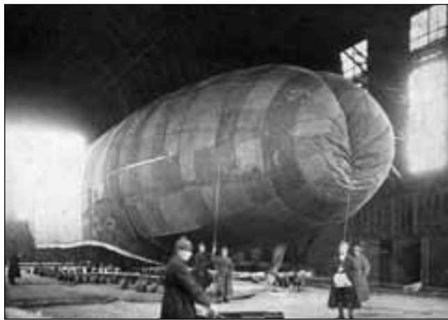
Наполнение оболочки дирижабля «VI Октябрь» в эллинге
