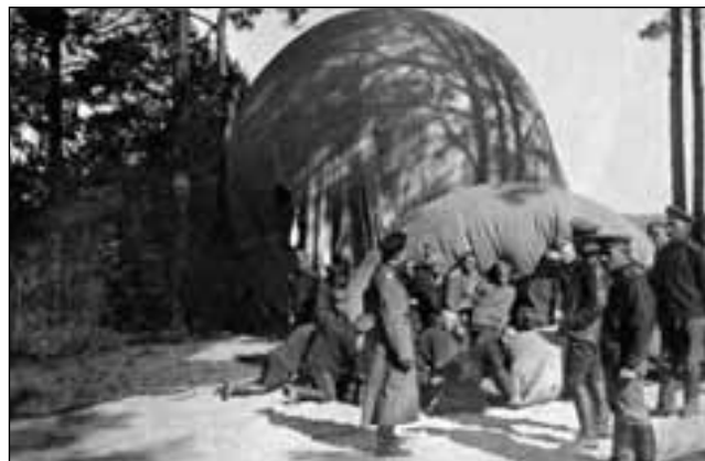
Переливание водорода из газгольдера в аэростат
