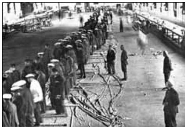
Подготовка к выносу оболочки дирижабля «СССР В-6» из баллонного цеха в эллинг
