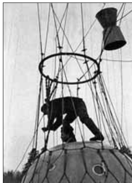
Проверка крепления гондолы «Осоавиахим-1»
