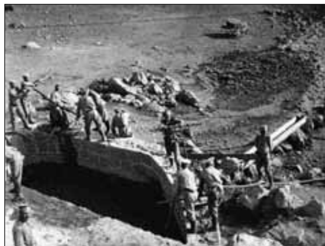
Подача ручным насосом воды в алюминиево-щёлочной газодобывательный аппарат из бассейна в районе Сарыкамья во время подвижных сборов 1-й Кавказской воздухоплавательной роты в Карской области в 1913 г. В следующем году эти места стали ареной ожесточённых боёв
