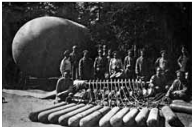
Срочное наполнение змейкового аэростата через коллектор от баллонов со сжатым водородом
