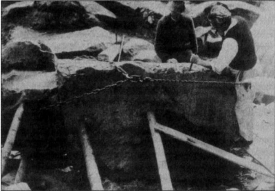
Во время реконструкции сооружений у «скалы гротов»
