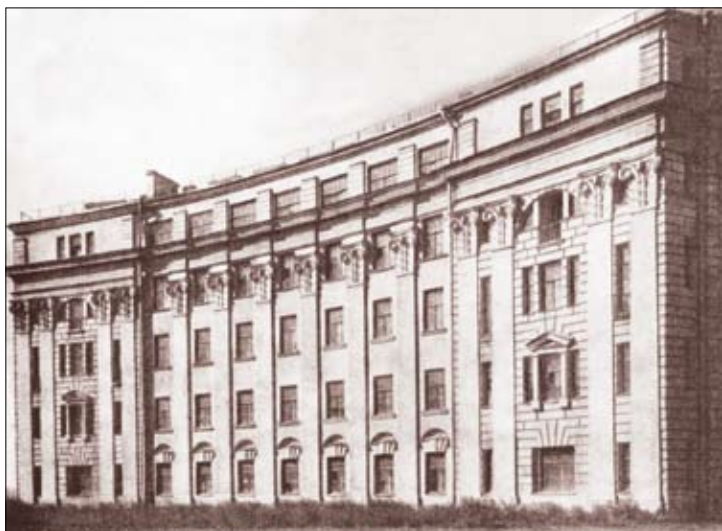
И. Фомин. Жилой дом на острове Голодай в Петербурге. 1912 г.
