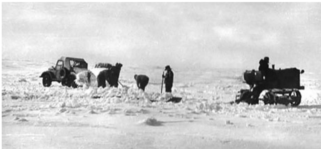
Расчистка ВПП возле «СП-11» с помощью ледово-фрезерной машины, трактора и лопат.
