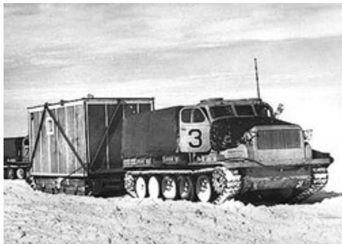
Гусеничный вездеход на базе армейского тягача АТ-Т.
