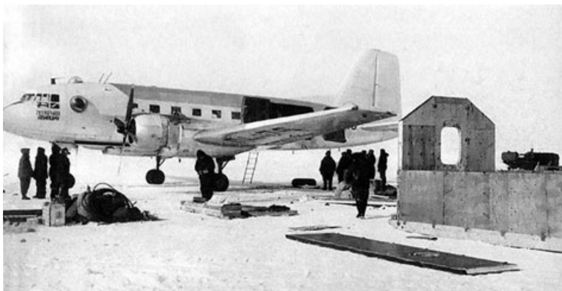
Разгрузка сборно-щитовых домов для дрейфующей станции «СП-12».
