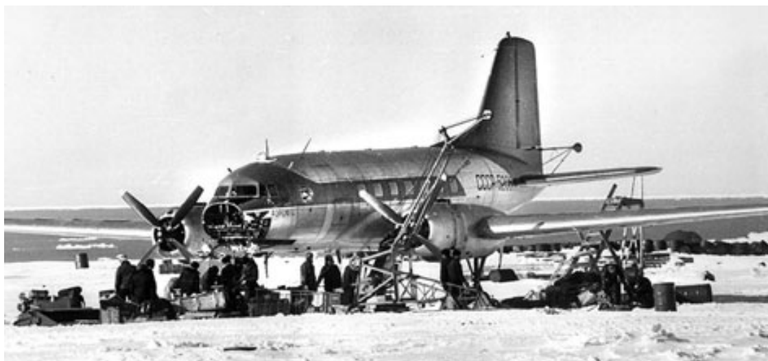
Сборка Ил-14 «СССР-52066» на снежном припаяе
