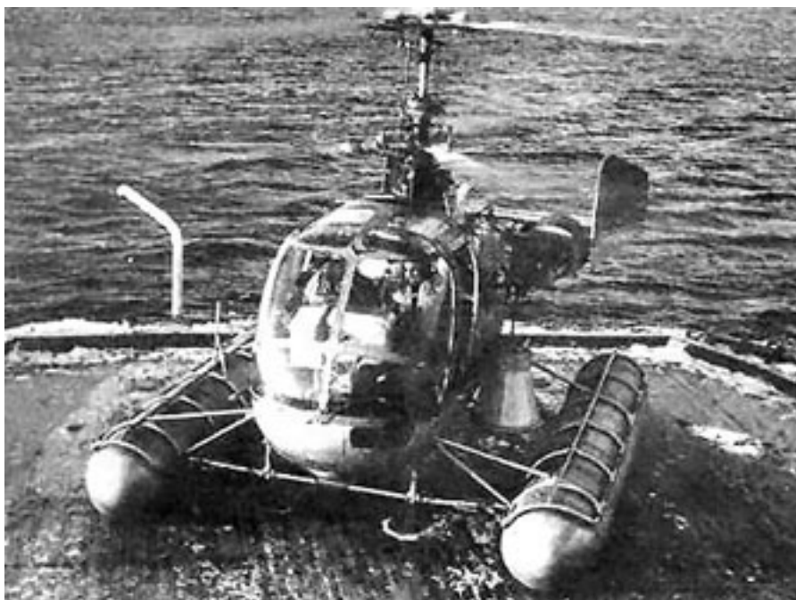
Вертолёт Ка-15 на посадочной площадке ледокола.
