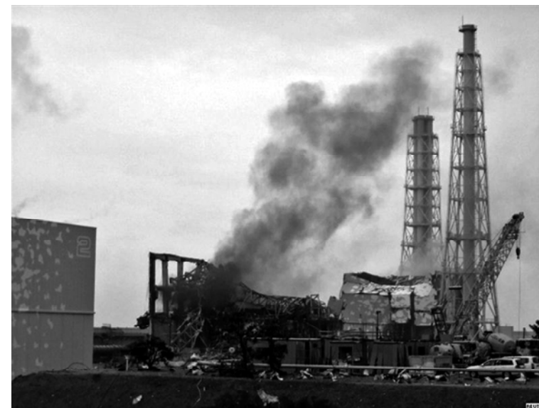
Фото 3-го блока АЭС Фукусима после взрыва.
