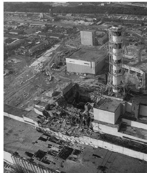
Разрушенный реакторный зал блока №4, вид со стороны маизала (южная сторона).
