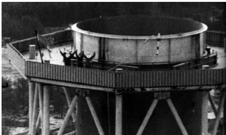
Флаг на вентиляционной трубе третьего и четвертого энергоблоков ЧАЭС.
