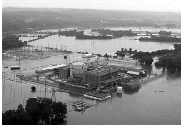
АЭС Форт Калхун: Здание, где хранилось отработанное топливо, затоплено водой.
