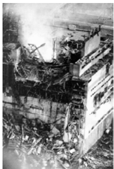
Вид на северную сторону разрушенного энергоблока. Виден вынос паров воды и радиоактивных продуктов в атмосферу.
