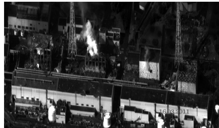
Фото АЭС Фукусима со стороны океана. Самый правый – блок №1. На переднем плане здание турбинного отделения, в котором расположены аварийные дизель-генераторы и распределительные устройства.
