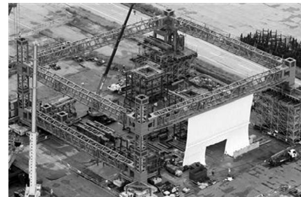
Первые фрагменты колпака на причале Фукусимы.
