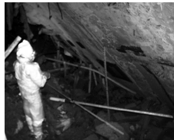
К. Чечеров в реакторе 4-го энергоблока, под упавшей бетонной панелью. Реактор пуст.
