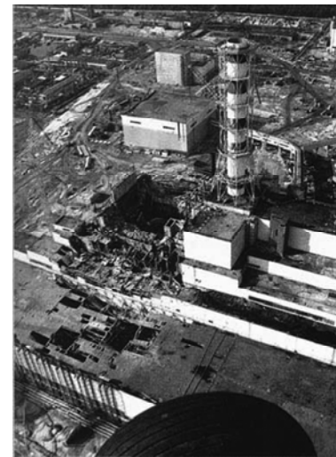
Участок №1 – крыша машзала (на переднем плане). Рядом с основанием вентиляционной трубы видны кровли зданий, на которых работали пожарные участка №2 (справа от трубы видна кровля реакторного зала энергоблока №3).
