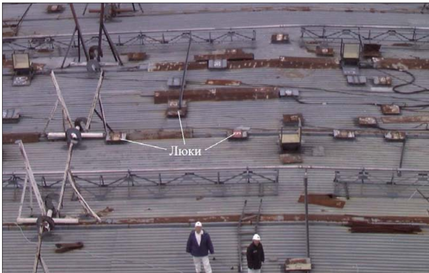
Рис. 1. Расположение технологических люков в кровле центрального зала, через которые опускались КДШ
