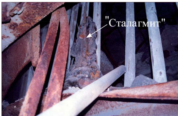
Рис. 8. Полихромная лава (сталагмит) в подапаратном помещении 305/2
