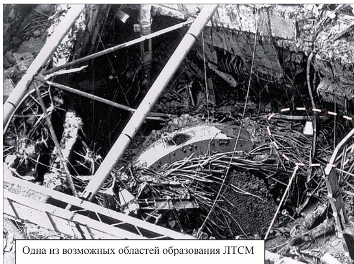
Рис. 18. Расположение гипотетической области образования полихромных ЛТСМ в районе отметок +24.000 – +35.000[10]
