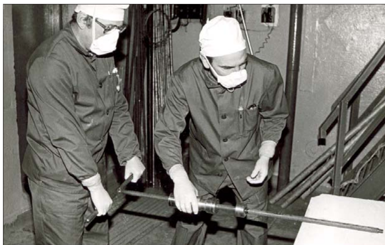
Рис. 8. Подготовка к отбору пробы через скважину
