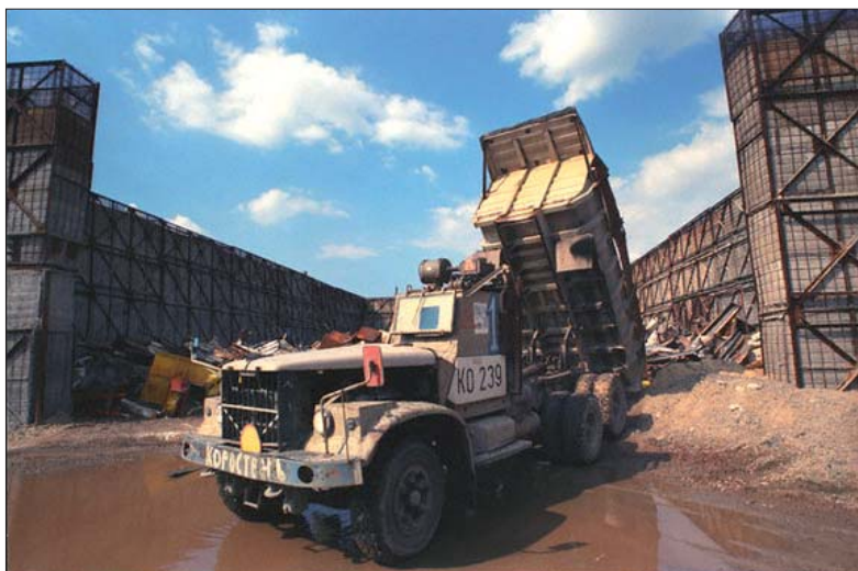
Рис. 7. Засыпка площадки чистым грунтом. Кабина водителя имеет дополнительную защиту
