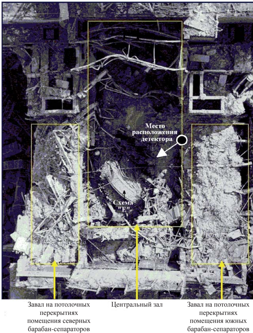
Рис. 7. Фото верхних отметок разрушенного 4-го блока. Отмечено место расположения коллимированного детектора
