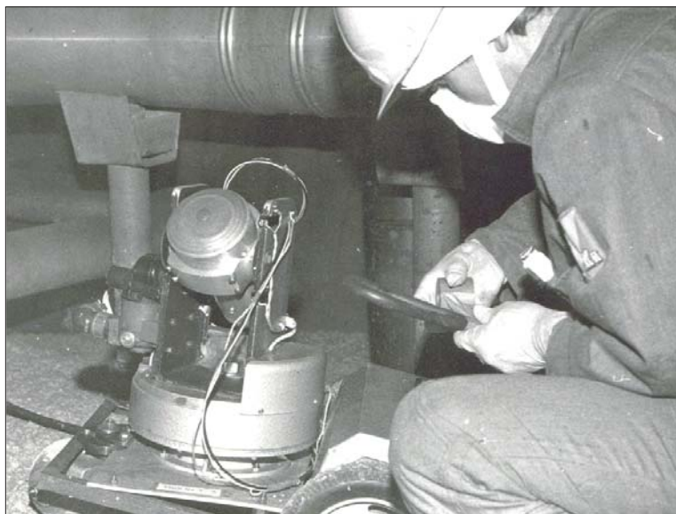
Рис. 11. Монтаж переносного гамма-визора
