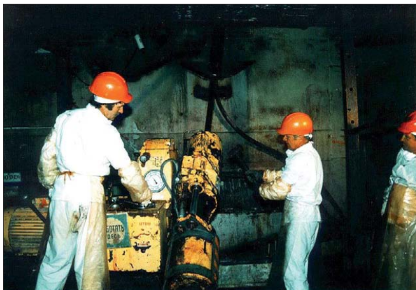
Рис. 3. Подготовка бурового станка к работе
