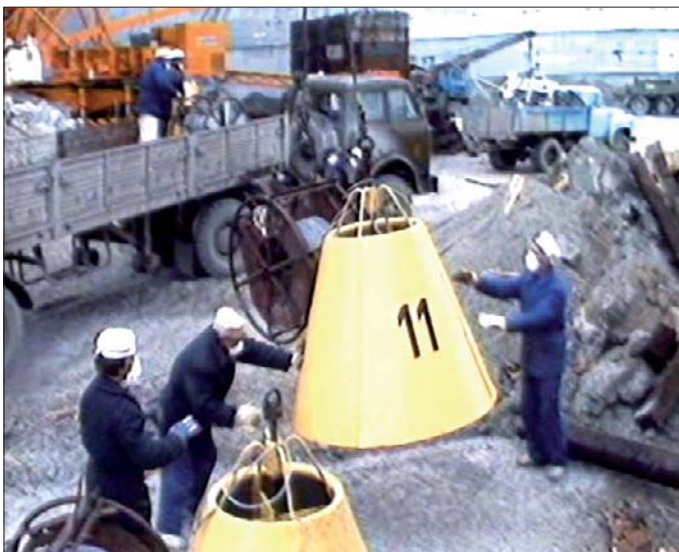
Рис. 15. Доставка Буев на площадку 4-го блока
