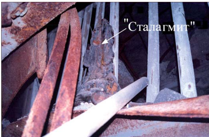
Рис. 20. Скопление лавы – «сталагмит», являющийся продолжением «сосульки» ЛТСМ, свисающей с бетонной плиты
