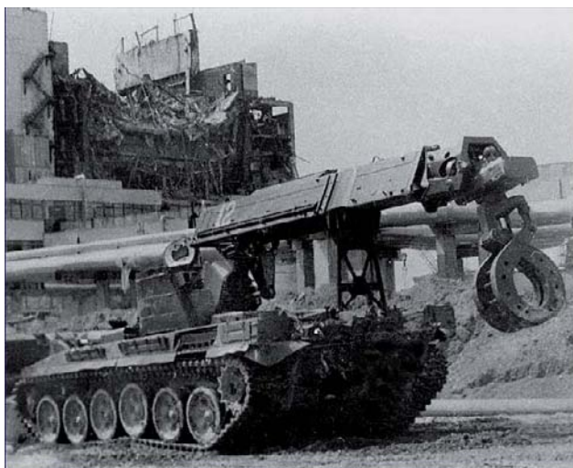
Рис. 5. ИПР на площадке 4-го блока
