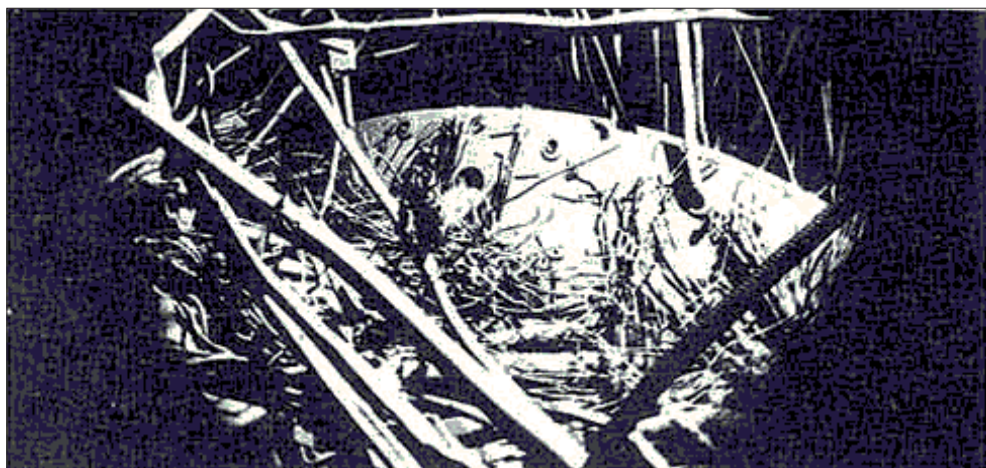
Рис. 10. Фотография шахты реактора, сделанная через перископ
