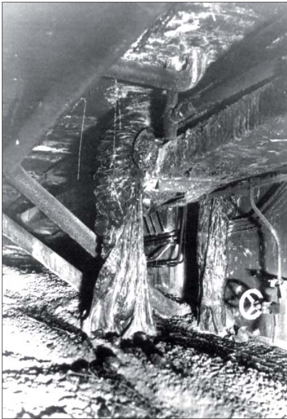
Рис. 3. Скопление ЛТСМ, получившее название «сталактит»
