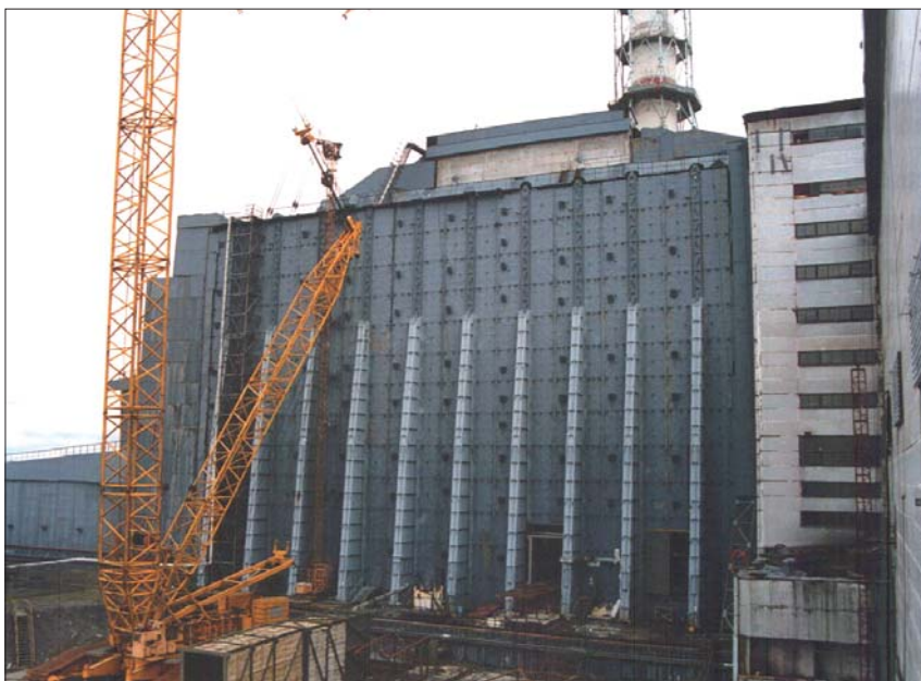
Рис. 3. Западная контрфорсная стена
