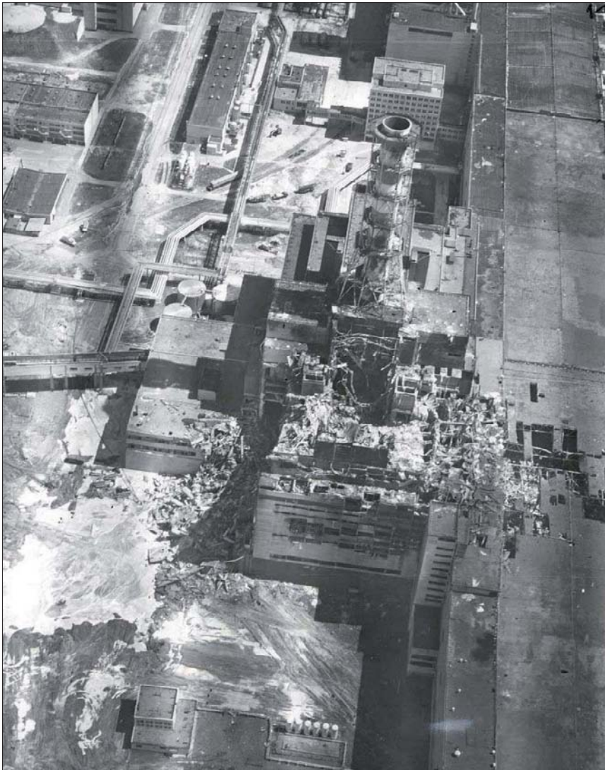
Рис. 1. Разрушенный 4 блок и площадка вокруг него. Съемка с вертолета. 14 мая 1986 г.
