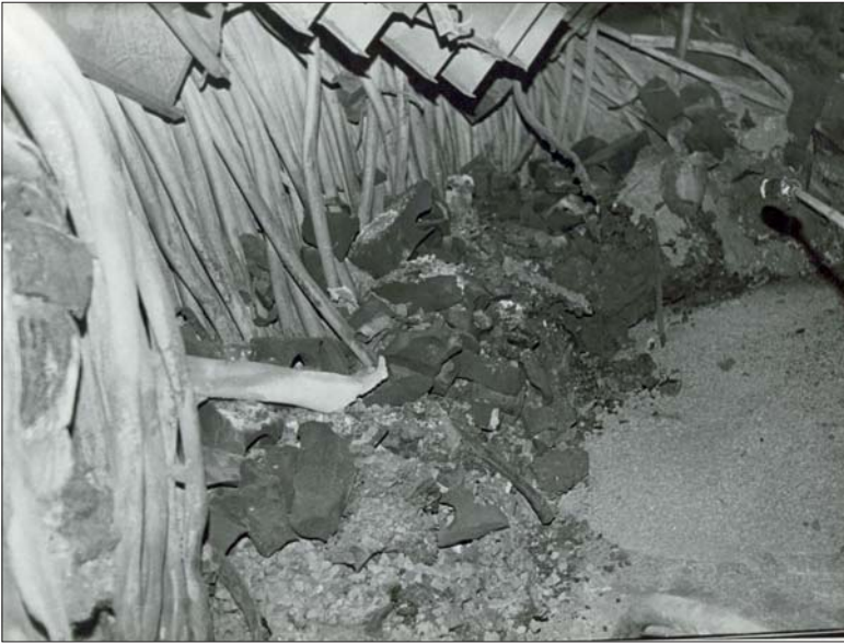
Рис. 22. Южный квадрант пом. 305/2. Под согнутыми трубами НВК – обгоревшие графитовые блоки
