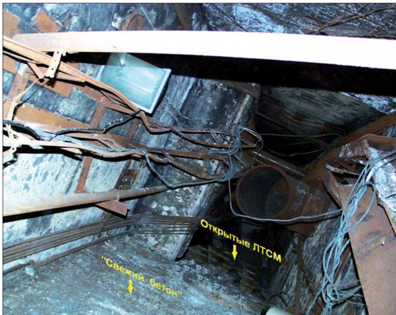
Рис. 24. Коридор 301/5, вид с запада на восток. Следующее помещение «горизонтального потока», в которое лава попала из пом. 304/3 через открытую дверь. Основная часть ее находится под слоем «свежего бетона» и только небольшой «язык» открытых ЛТСМ пересекает коридор (см. также рис. 17)
