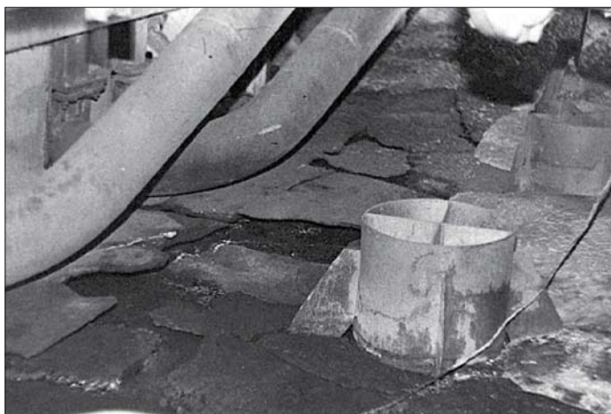
Рис. 27. ПРК. Застывший металл на полу пом. 210/5
