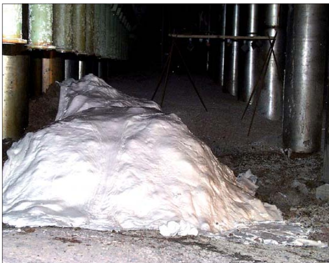
Рис. 32. «Куча» в ББ-1 после нанесения слоя ЭКОР для предотвращения разрушения поверхности ЛТСМ и распространения пыли
