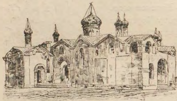
Церковь «Спасъ на - Бору».
