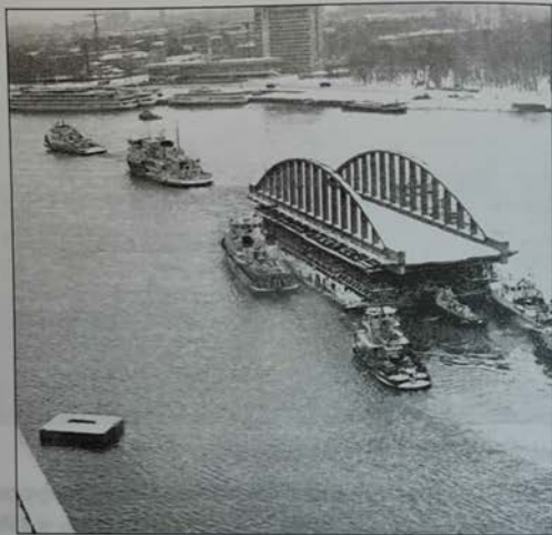
Буксировка конструкций старого Володарского моста. (Из фотоальбома «Петербургские мосты». СПб., 2006)
