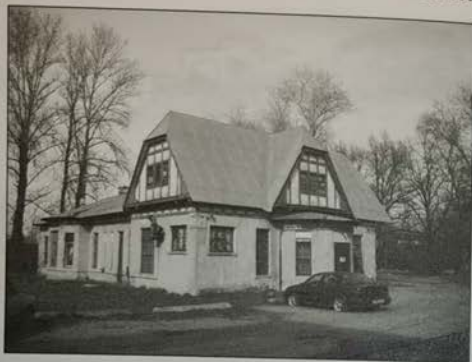
Здание амбулатории на территории бывшей фабрики «Торнтон». (ул. Тельмана, д. 10) Фотография автора. 2015 г.
