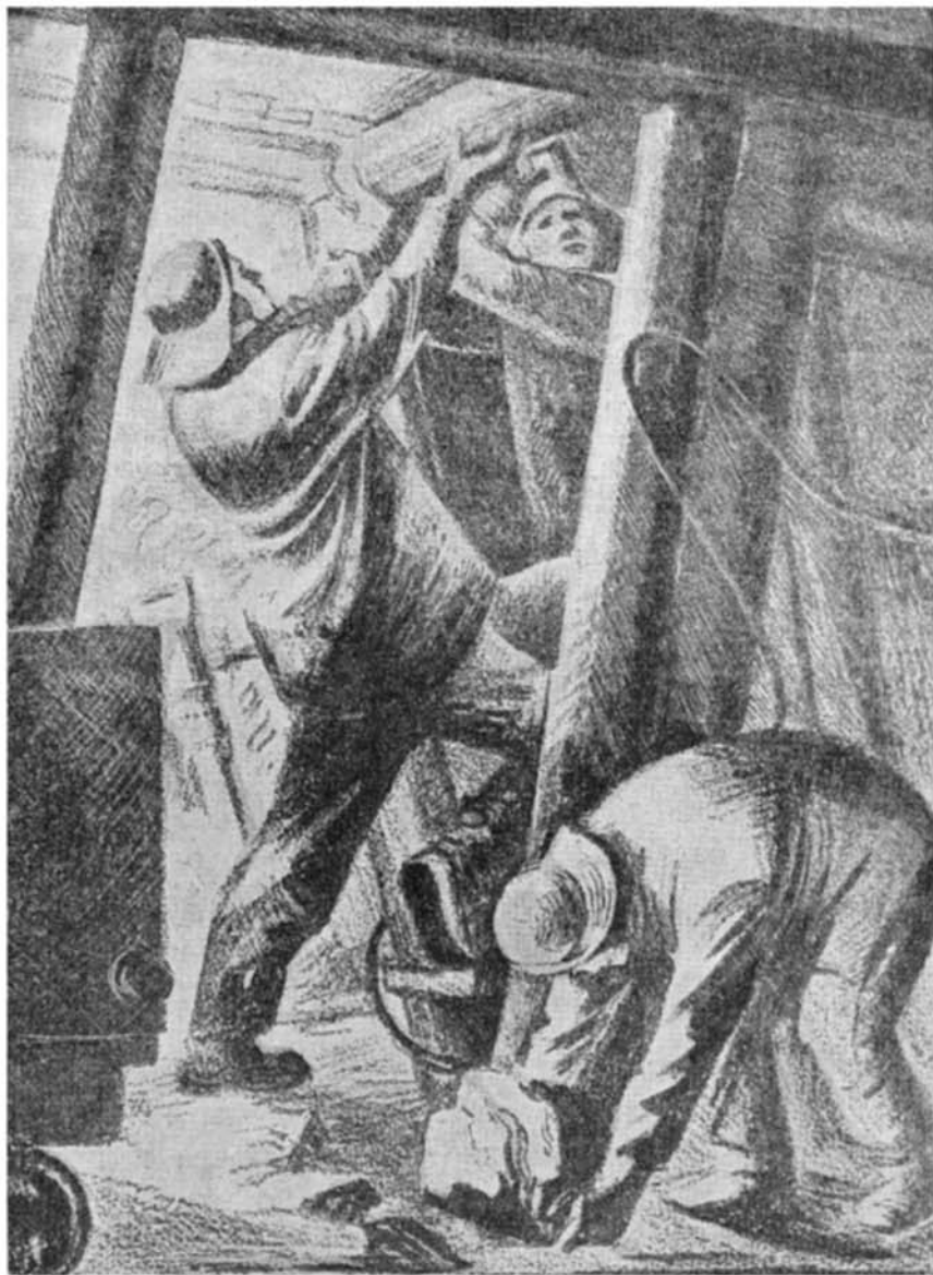
Установка деревянной опалубки в глубоком забое.
