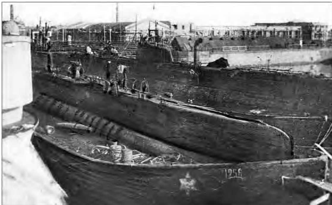
Погрузка отремонтированной подводной лодки на баржу для отправки на Волгу. 1920 г.
