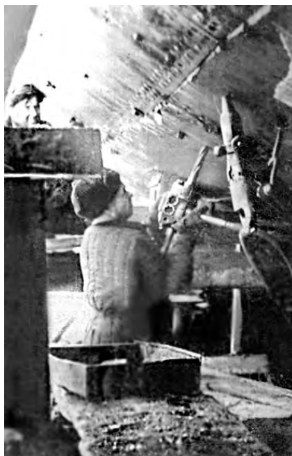
Ремонт одного из кораблей на Морском заводе
