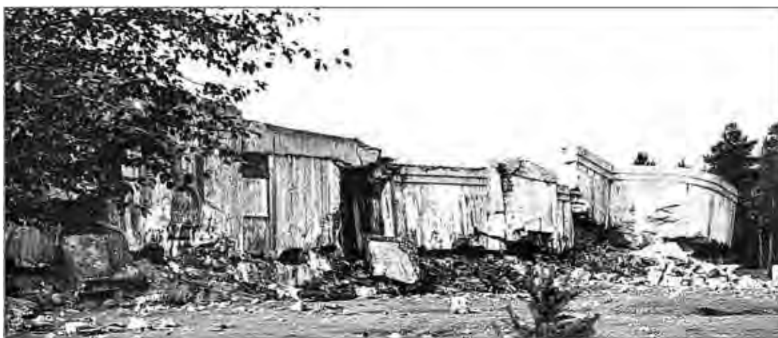
Взорванные сооружения форта «Ино»
