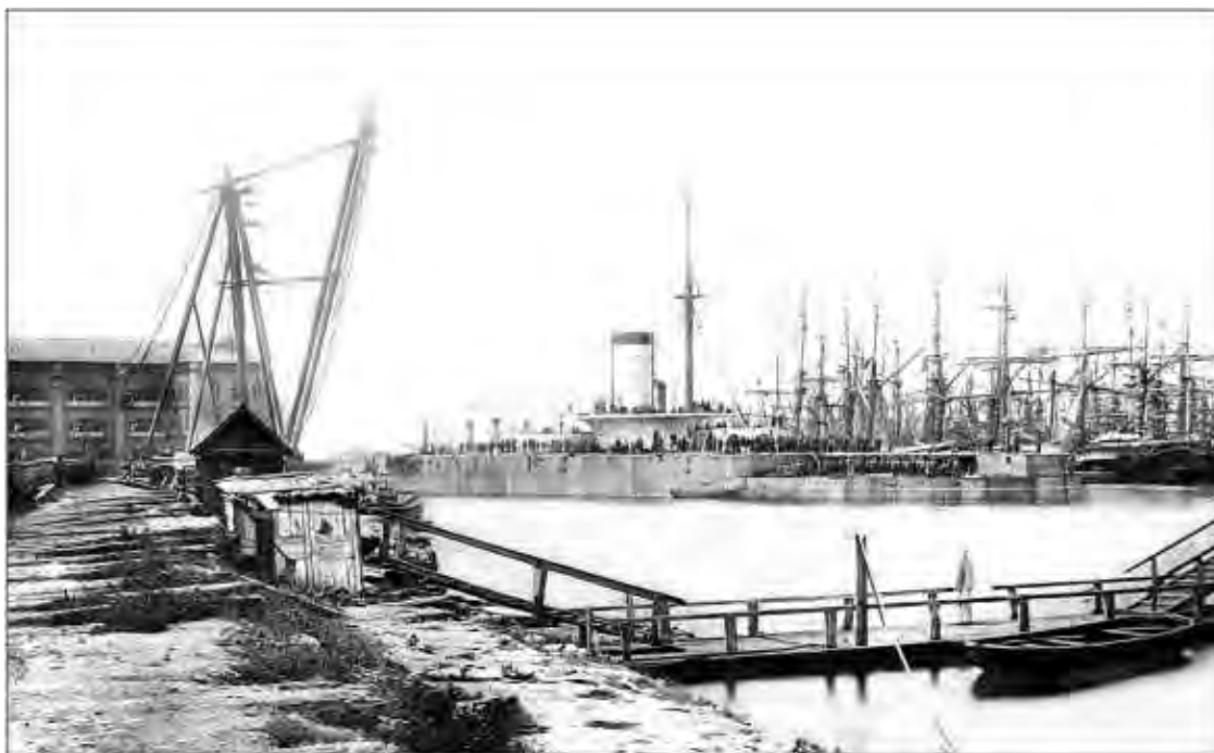
Броненосец «Петр Великий» на достройке в Кронштадте
