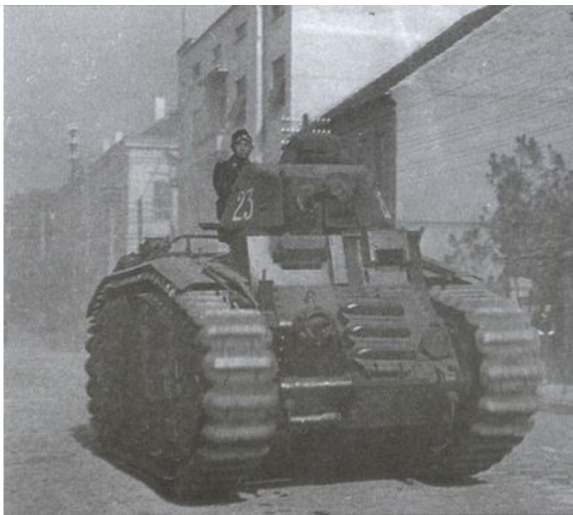
Французский танк В-1 bis, переделанный немцами в огнеметный
