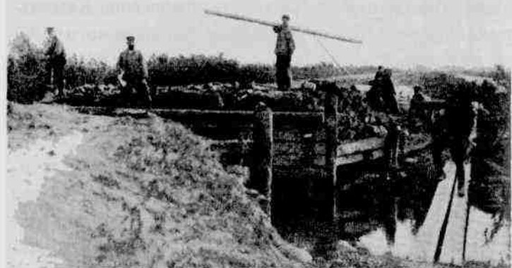
Разрушенная дамба на Приморской железной дороге
