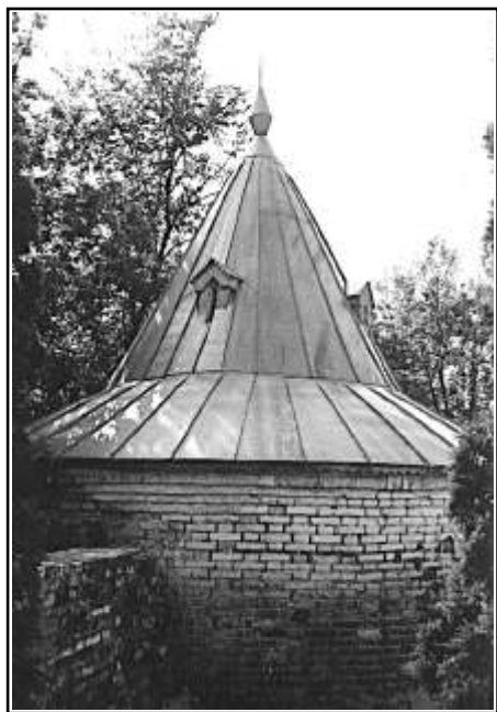
Башня, бывшая в XVIII веке угловой северо-западной — последняя из сохранившихся построек схиигумена Евсевия
