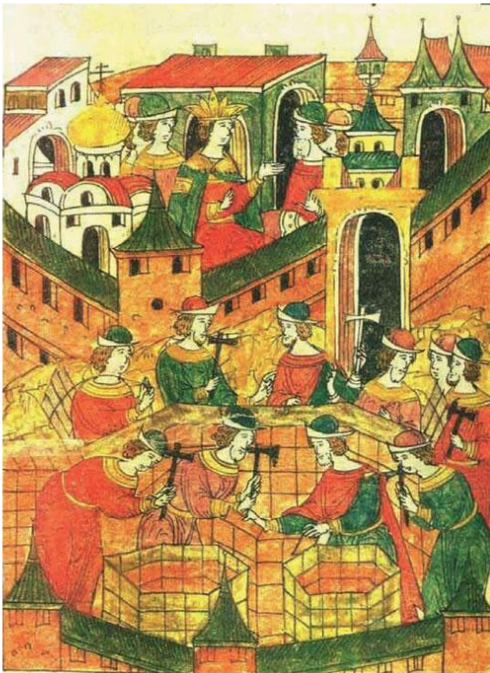
Строительство Храма Василия Блаженного на Красной площади. Миниатюра из Лицевого летописного свода. XVI в.
